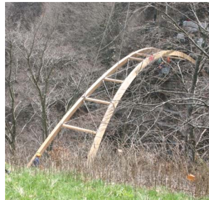
Montage des Haupttragwerks
