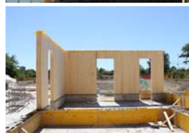
Fasi di montaggio
