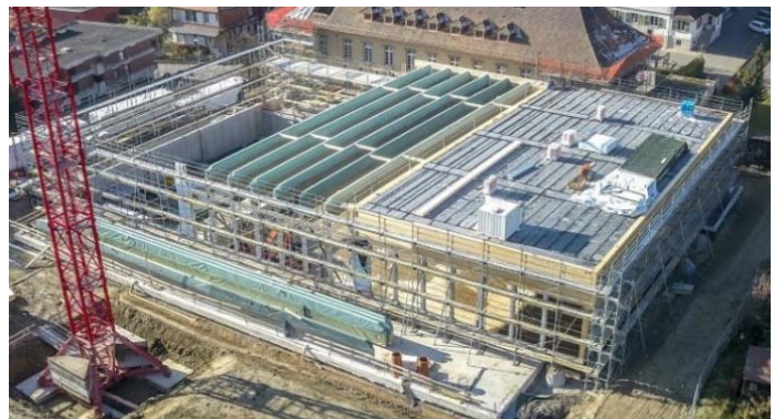
Vista dall'alto in fase esecutiva della posa travi principali
