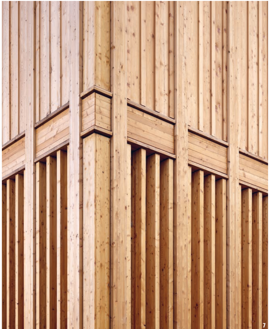
7 Wie alle Bauteile wurde auch die Fassadenschalung (Lärchenholz) in ihrer Materialität roh belassen.
